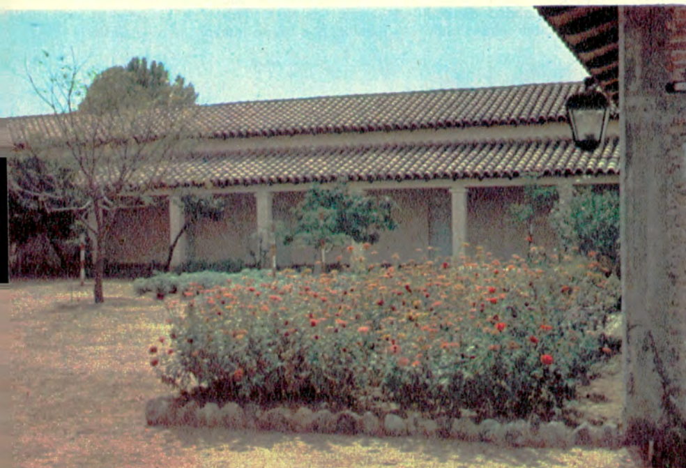
Aspecto de la extensa galería y patio central de la Hostería del A.C.A. en Cafayate.
